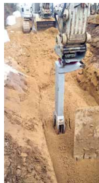
Travaux de reseaux et de canalisations
