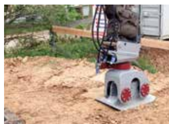
Travaux d'aménagement paysager
