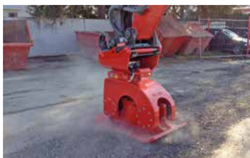
Travaux de voiries
