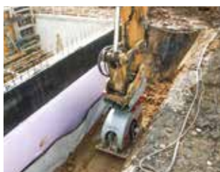
Construction de bâtiments
