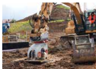
Travaux de terrassement
