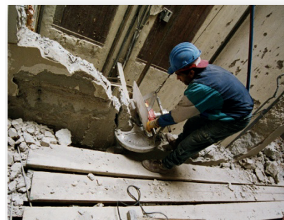
Démolition avec outils à main
