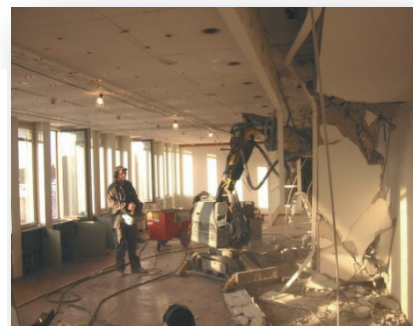
Démolition avec robots
